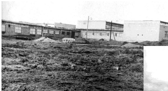
Fot. Plac budowy w latach 1966-70
